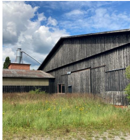
Ruderalvegetation vor Gebäude (Blickrichtung Nordost)
