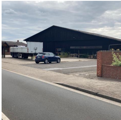
Versiegelte Bereiche (Blickrichtung Westen)
